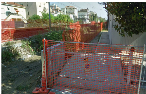
Fig. 36 - Avanzamento cantiere altezza via Capizucchi agosto 2014
