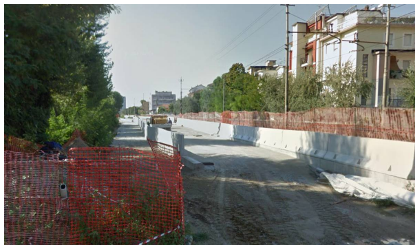
Fig. 35 - Avanzamento cantiere altezza via del Giglio agosto 2014
