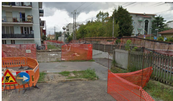
Fig. 34 - Avanzamento cantiere altezza viale B. Neri settembre 2014
