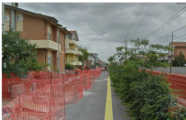
Fig. 37 - Avanzamento cantiere su via Giacometti settembre 2014
