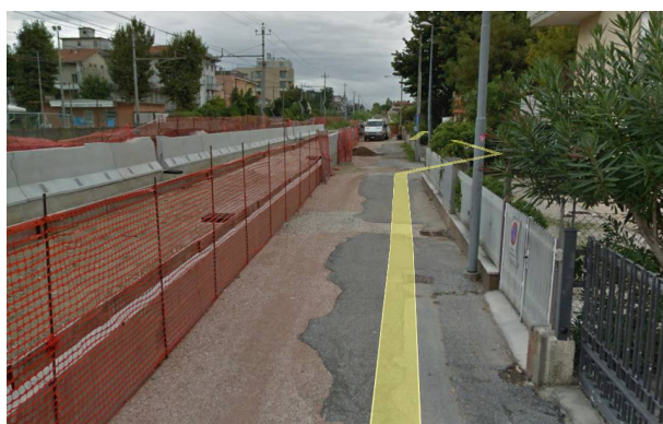
Fig. 38 - Avanzamento cantiere su via Filangeri settembre 2014
